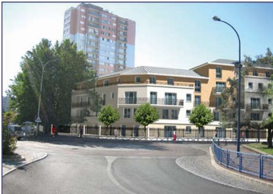
* Les travaux de construction du nouveau groupe scolaire du quartier Sémard et le gymnase qui lui est associé
